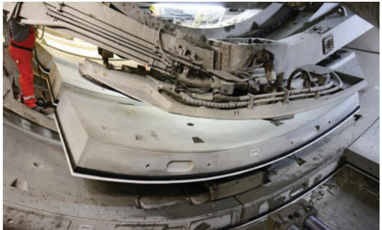
Einer der Tübbinge wird von einer Hubeinrichtung gepackt und anschließend an der vorgesehenen Position abgelegt
