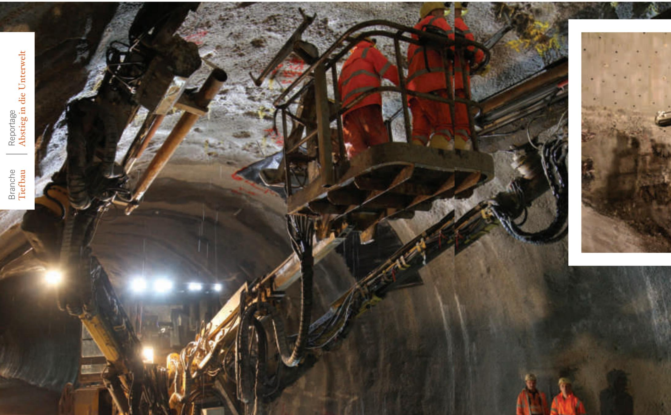
Das Bohrgerät treibt binnen Minuten tiefe Löcher ins Gestein. Entlang der Tunneldecke werden sie mit Zement verfüllt. Die übrigen Bohrungen werden mit Sprengstoff gefüllt. Nach Anfahrt wird die Maschine ans Starkstromnetz angeschlossen
